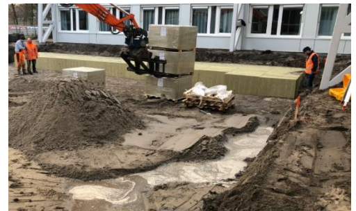
Figuur 38 Steenwol als ondergrondse berging
